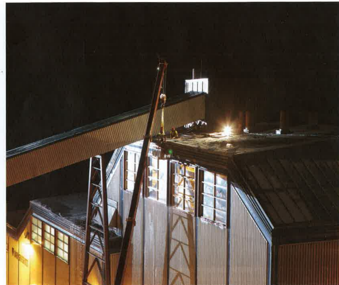
HØYT: Taket på Energiverket er 27 meter høyt, der hvor det brant. – Bilene så ut som lekebiler nede på parkeringsplassen, sier brannmester Geir Hekne. Det var her, i taket over fyrrommet, brannen startet. Transportbeltet som frakter kull inn i Energiverket lå faretruende nær, men ble ikke skadet.
