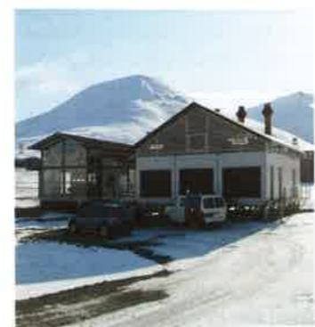
RESERVEN: Reservekraftstasjonen (t.h.) styres fra Energiverket. FOTO: LINE N. YLVISÅKER
